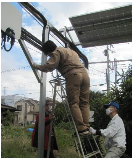
架台の点検作業
