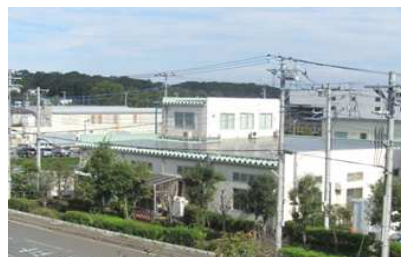
工場の屋根に設置 (所沢市林)
