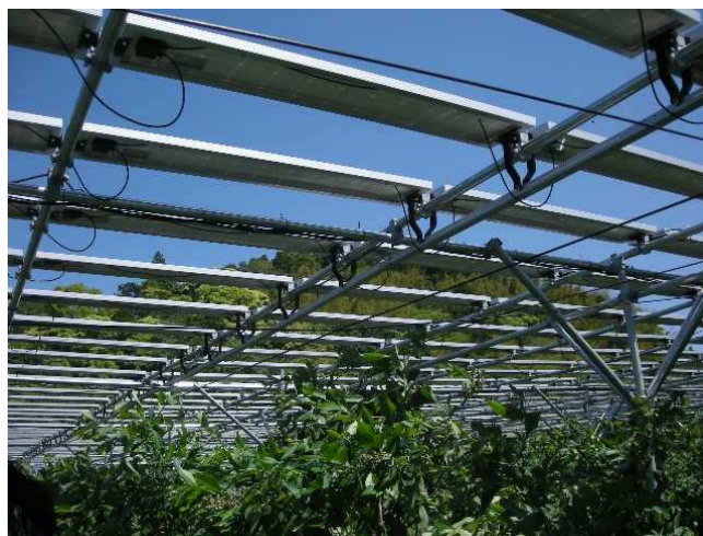
細幅ソーラーパネル(いすみ市)
