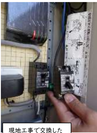
現地工事で交換したブレーカー
