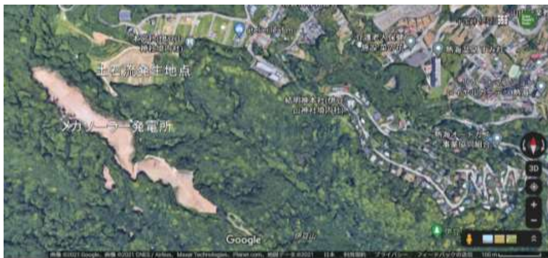
写真は熱海伊豆山の太陽光発電所
